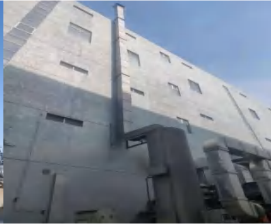
(NMP 回收系统废气排放口)
